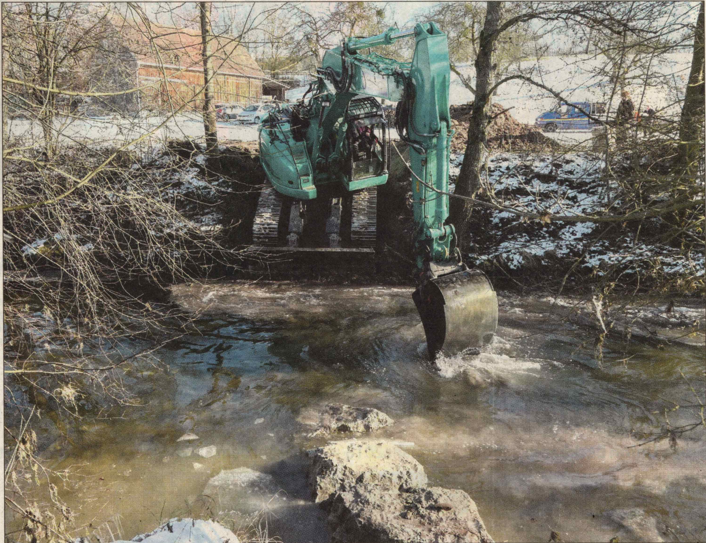
Ein Bagger verlegt Steingruppen und einzelne, schwere Störsteine, um die Struktur im Bachbett der Murr zu verbessern.
